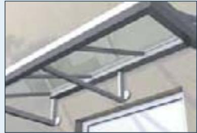
Bei Dächern mit Übergrößen muss aus statischen Gründen ein zusätzlicher Stützbügel in der Mitte des Vordachs montiert werden.
